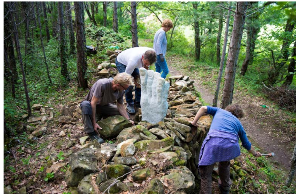
Artistas y profesionales de la piedra seca trabajando en una intervención de un tramo en Saoû, Murets d'Art 2016 (Francia)
